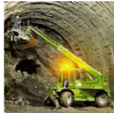
Arbeitsplattform, die mit einem Teleskopstapler zusammengebaut ist
