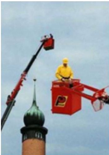
Arbeitsplattformen, die mit Ladekränen zusammengebaut sind
